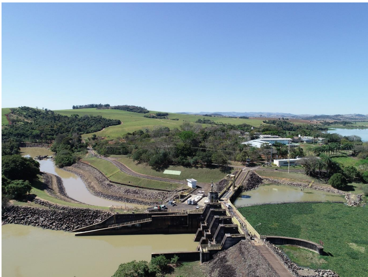
Figura 1 – Vista geral da barragem da PCH Mogi Guaçu
