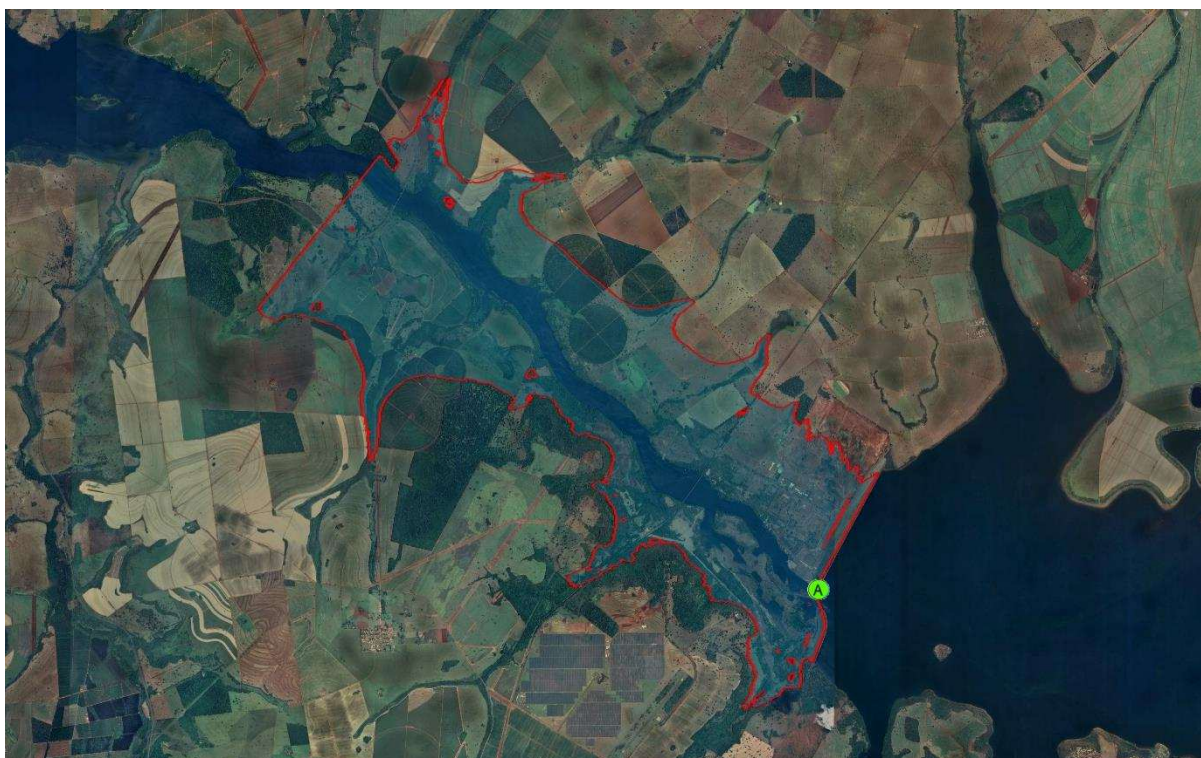
Figura 4 – Zona de Autossalvamento da UHE Água Vermelha
