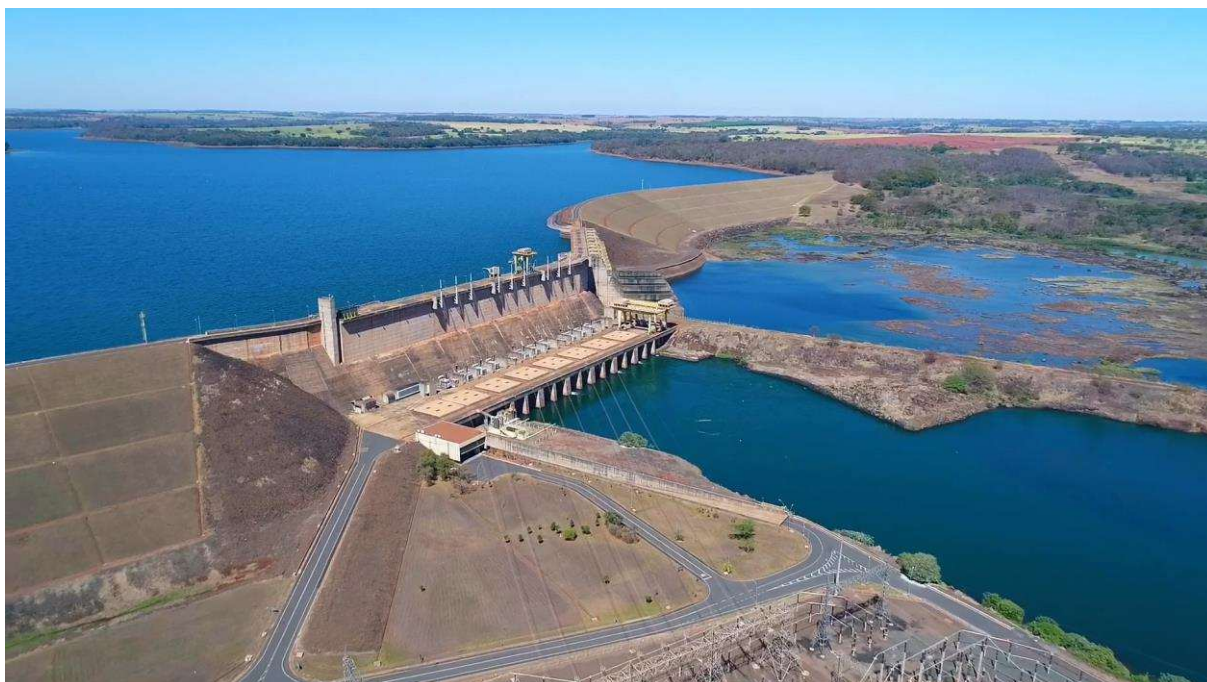
Figura 2 – Vista geral da barragem da UHE Água Vermelha
