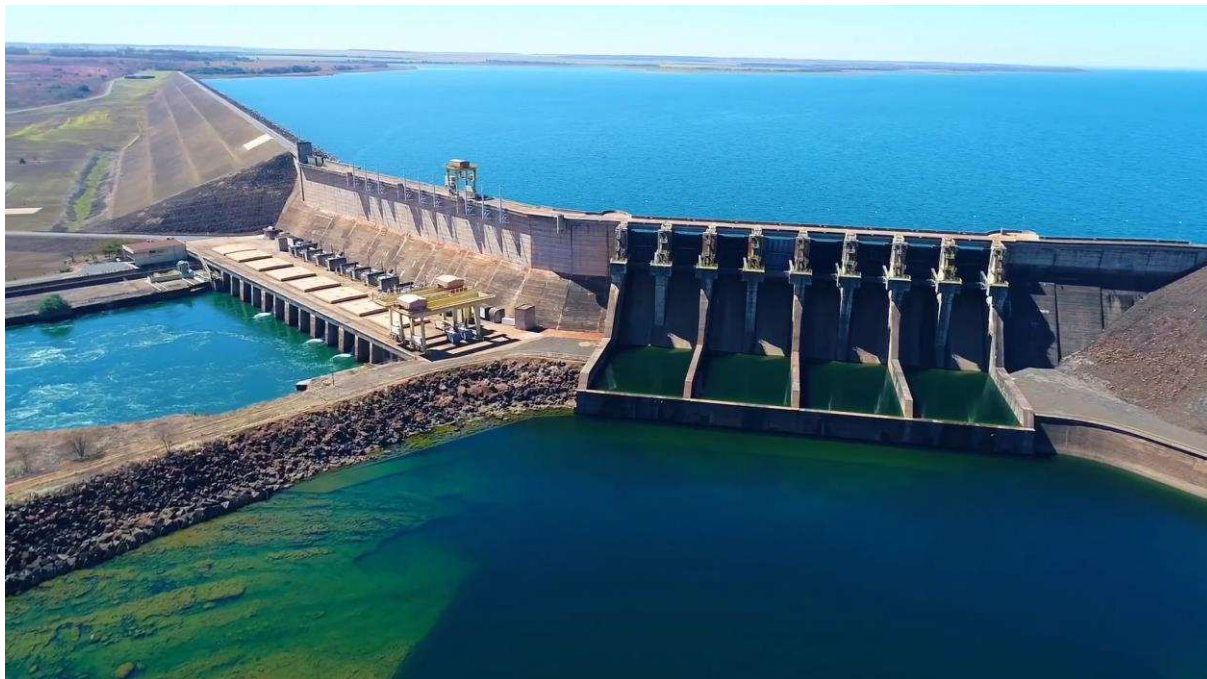
Figura 1 – Vista geral da barragem da UHE Água Vermelha
