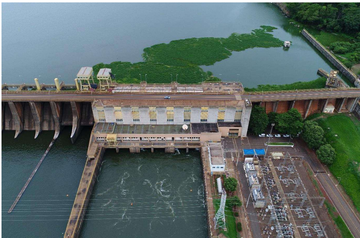
Figura 1 – Vista geral da barragem da UHE Bariri
