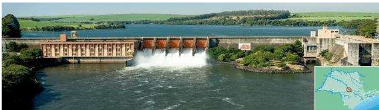
Figura 1 – Vista geral da barragem da UHE Barra Bonita
