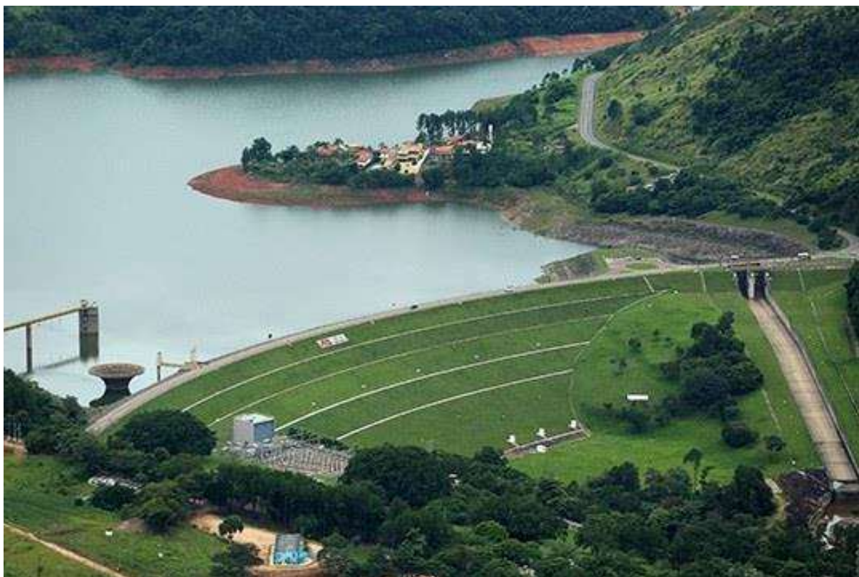
Figura 1 – Vista geral da barragem da UHE Caconde
