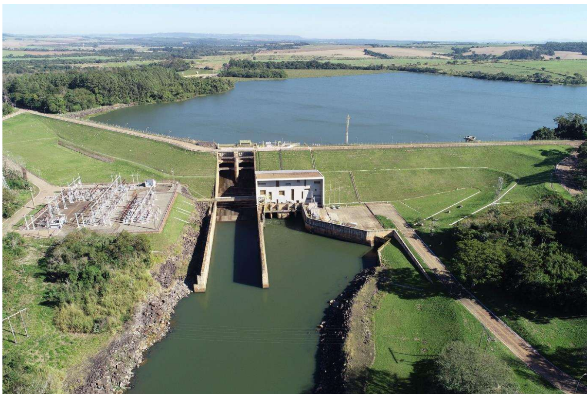
Figura 1 – Vista geral da barragem da UHE Limoeiro
