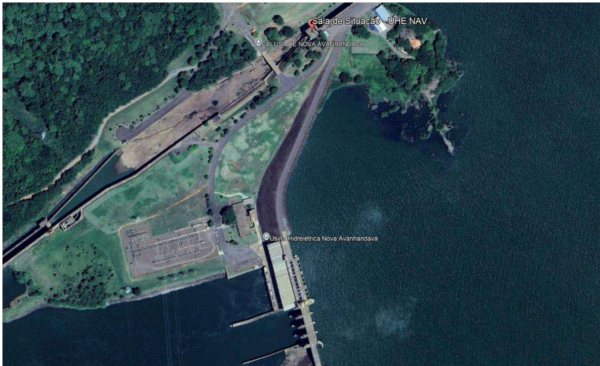
Figura 10 – Localização da sala de situação da UHE Nova Avanhandava
