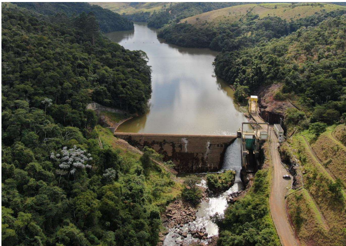
Figura 1 – Vista geral da barragem da UHE Picada
