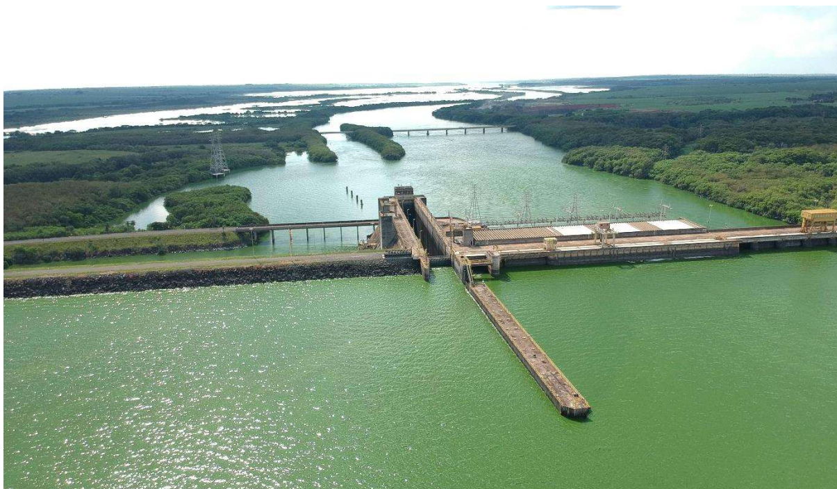
Figura 1 – Vista geral da barragem da UHE Promissão
