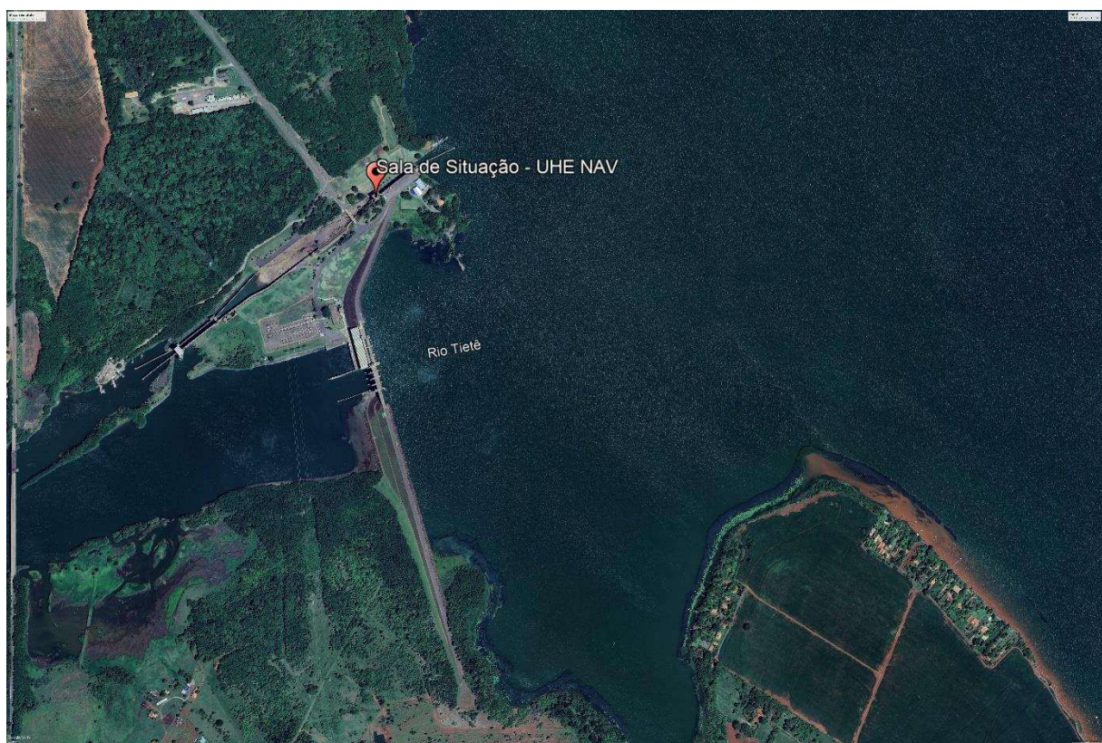
Figura 11 – Sala de Situação para Gerenciamento de Crise
